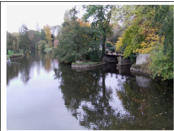
Aval du pont
